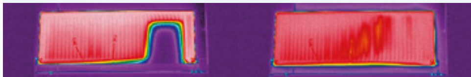
PRIMA: Zona fredda per presenza di fanghi
