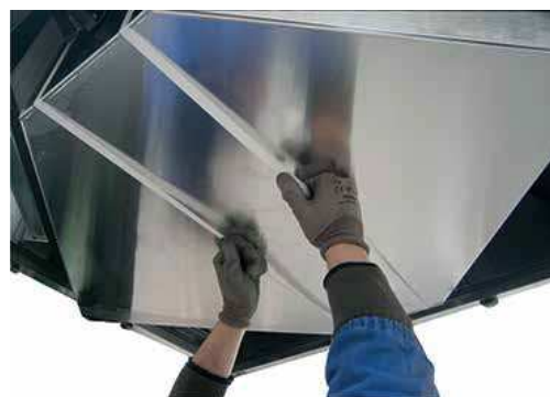
Estrazione scambiatore
